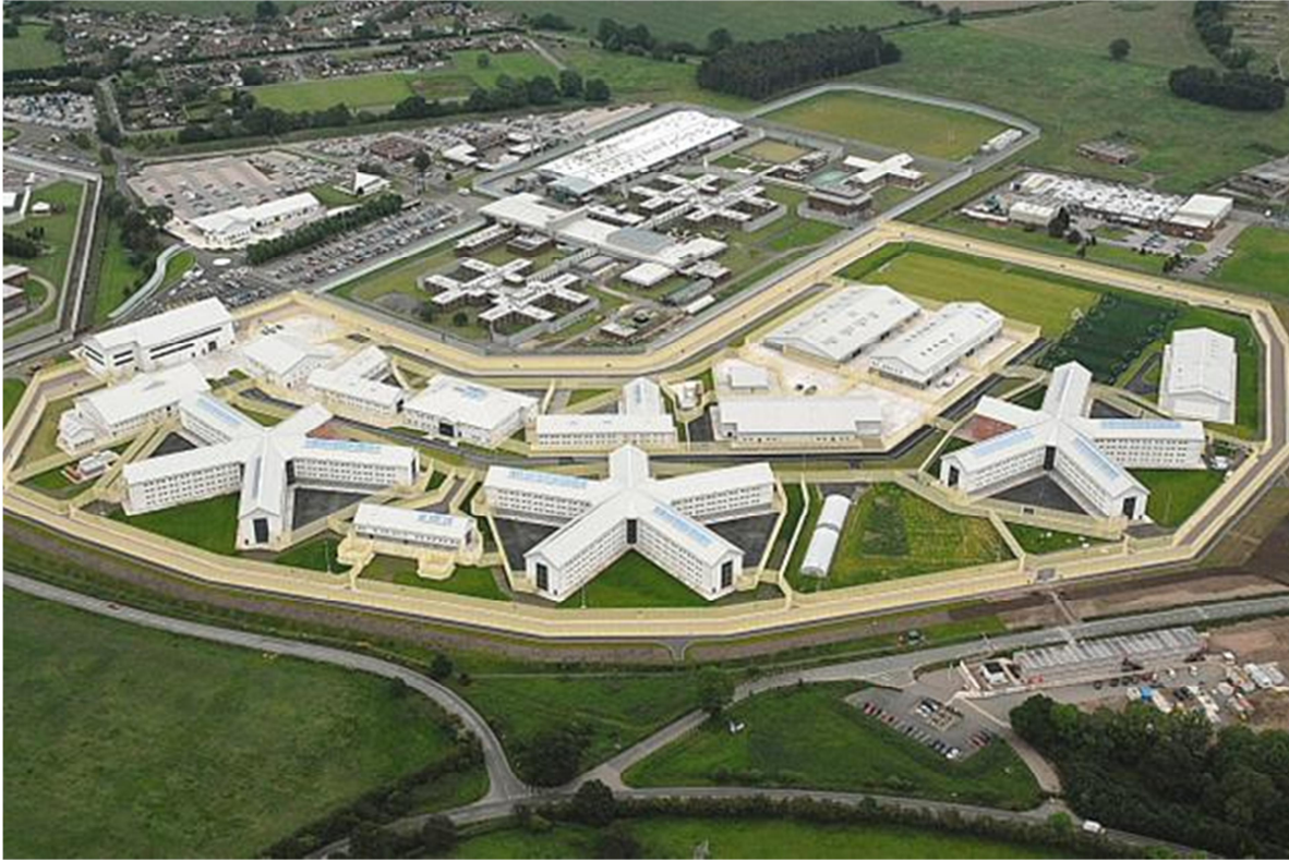
Слика 1: НМР Oakwood, Стафордшир, Енглеска, комплекс највећег приватног затвора Велике Британије. Извор: CE Controls ventilation improves safety and saves energy at new prison ; Building Talk, 2013.
